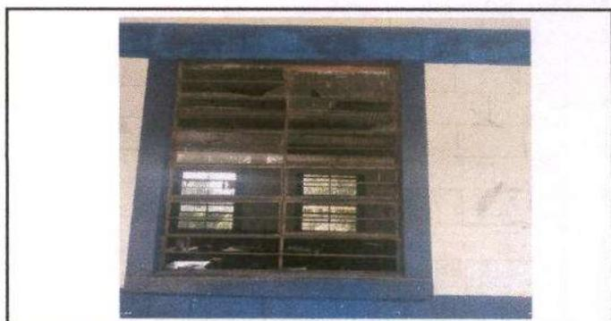
Foto 12: Sustitucion de balcon de metal
